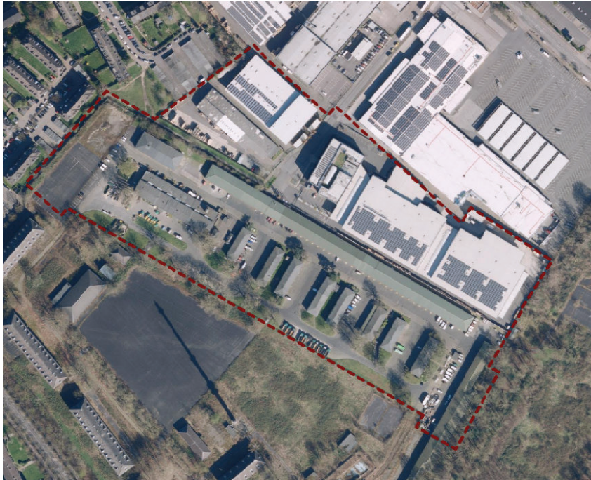
Abb. 12: Räumlicher Geltungsbereich des Bebauungsplans Nr. 723; Stand: Beschluss zur frühzeitigen Öffentlichkeitsbeteiligung am 29.08.2007 (Quelle: Geobasisdaten der Kommunen und des Landes NRW © Geobasis NRW)
