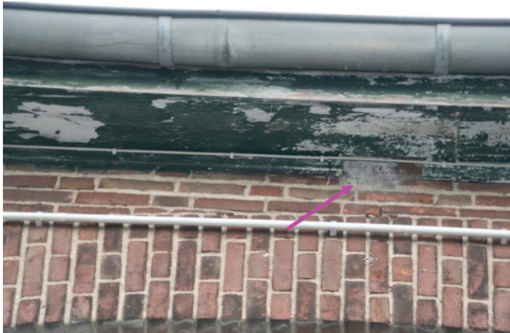
Abb. 13: alter Traufkasten mit spaltenförmiger Öffnung und eventuellen Kotspuren (Quelle: Weluga Umweltplanung, Artenschutzrechtlicher Fachbeitrag Stufe II, Seite 12)
