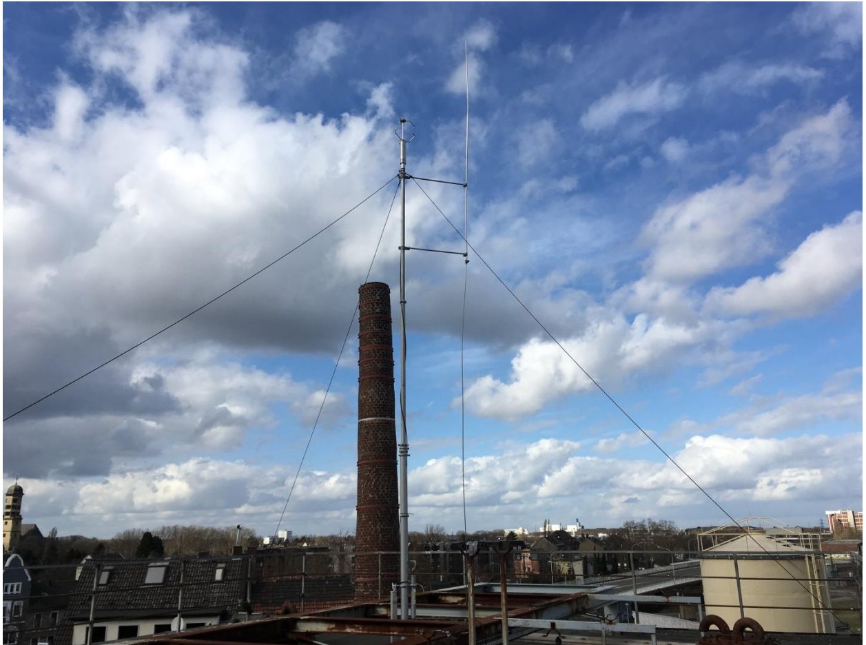
Abbildung 11: Meteorologische Messstation auf dem Dujardin-Gebäude
